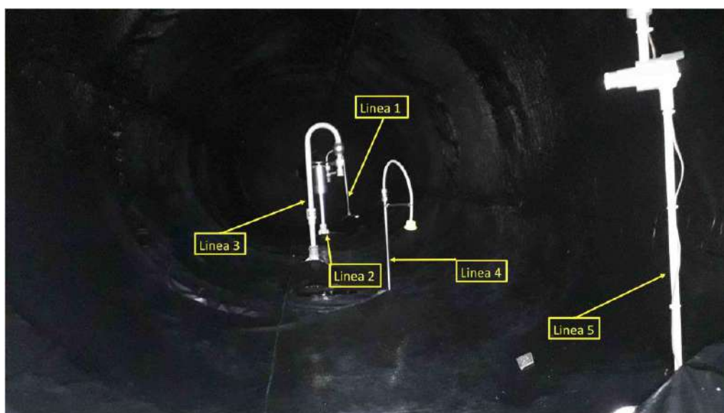
FIGURA 7: DISPOSIZIONE DELLE CINQUE LINEE DI PRELIEVO ALL'INTERNO DELLA CAMERA DI CAMPIONAMENTO, IN PRIMO PIANO LA LINEA DI PRELIEVO N°5 PIÙ PROSSIMA ALLA BOCCA DI USCITA DELLA CAMERA DI CAMPIONAMENTO (SI VEDA FIGURA 5).
